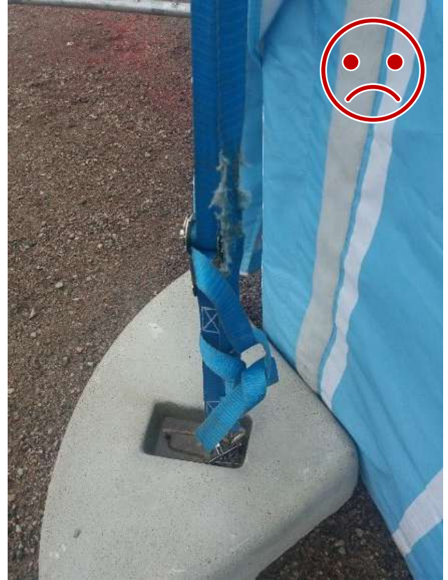
Kuva 10 EI NÄIN. Kuormaliina on kulunut.
