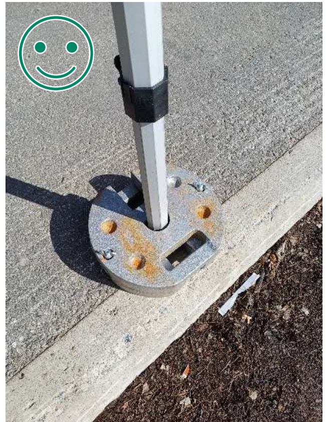
Kuva 2 HYVÄ TAPA. Molemmat painot kiinnitetty siipimutterilla molemmin puolin. Hevoskenkäpainot vastakkain, jolloin tolppa ei pääse irtoamaan rakenteen liikkeessa. Kulmatolpan maajalan tulee kestää kyseinen paino.
